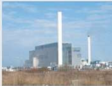
MVA Malmö (S)
